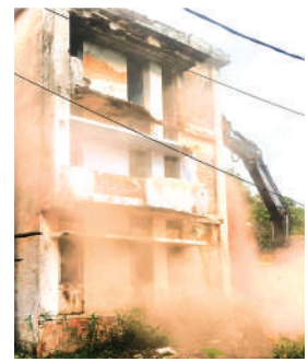
जर्जर घर ढहाती जेसीबी।
